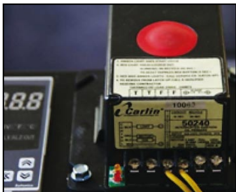
Контролер горелки
